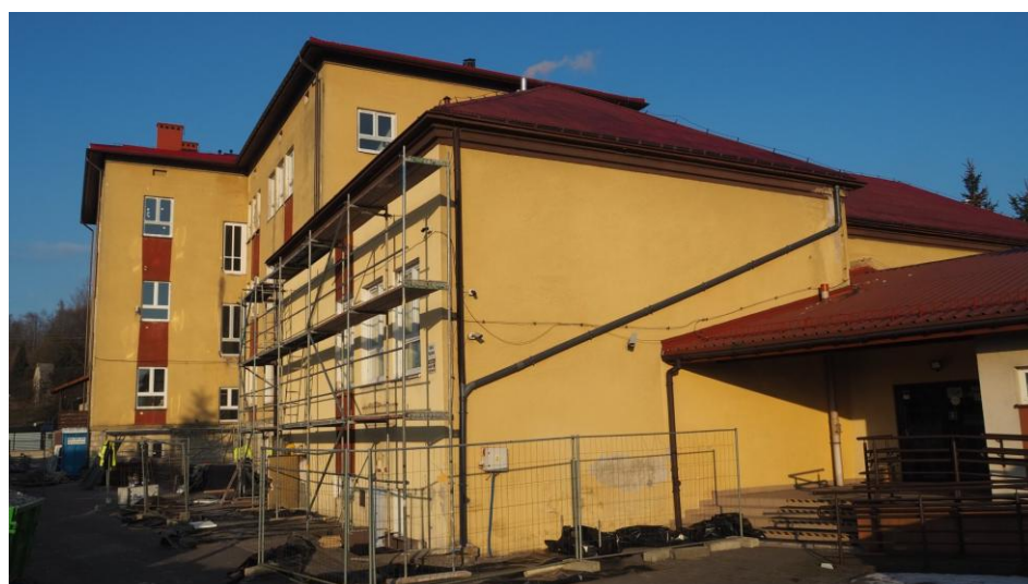
Modernizacja budynku Samorządowego Zespołu Szkół nr 1 im. A. Mickiewicza w Chełmku w ramach zadania: Modernizacja infrastruktury szkolno - przedszkolnej w mieście Chełmek.
