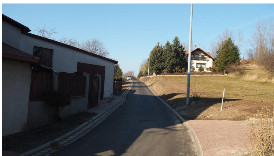
Roboty budowlane związane z remontem ul. Na Skałce w Chełmku.
