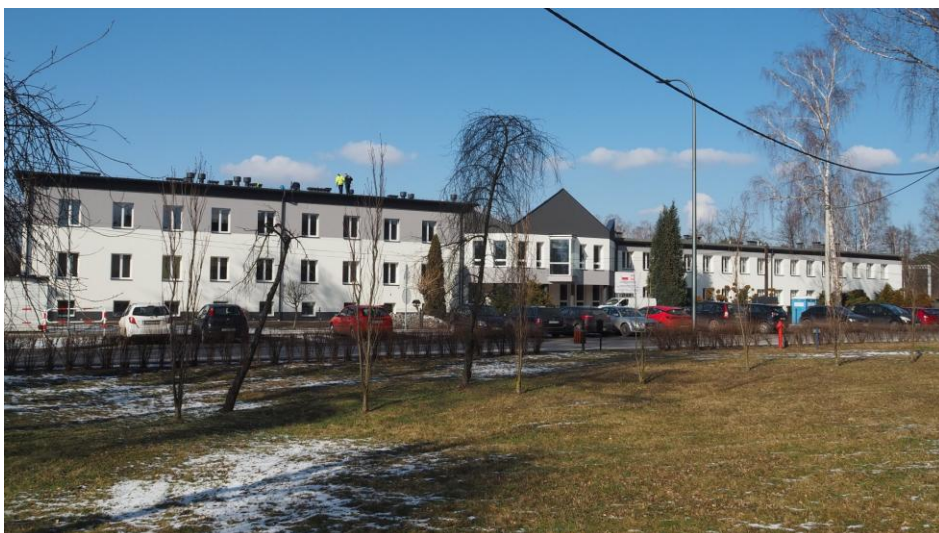
Modernizacja budynków Samorządowego Zespołu Szkolno – Przedszkolnego nr 2 w Chełmku przy ul. Brzozowej w ramach zadania: Modernizacja infrastruktury szkolno - przedszkolnej w mieście Chełmek.
